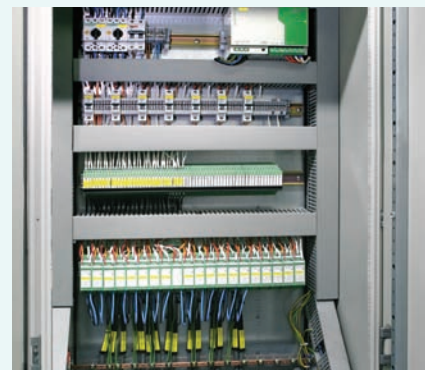
Nieuwe metingen resulteerden in een bijkomende stuurkast met onder andere stroomomvormers van Phoenix Contact.
