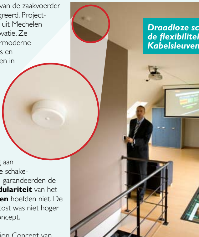
Eén ontvanger (tegen het plafond) kan radiosignalen ontvangen van vijftig draadloze schakelaars. De mobiliteit van de schakelaars verhoogt de flexibiliteit van het gebouw.
