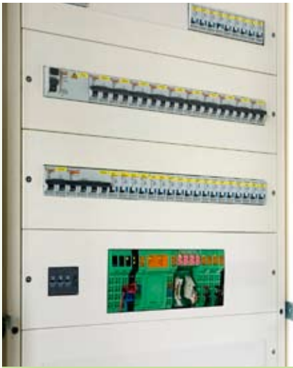
De ILC200-plc is modulair opgebouwd. Phoenix Contact programmeerde vooraf de volledige aansturing.
