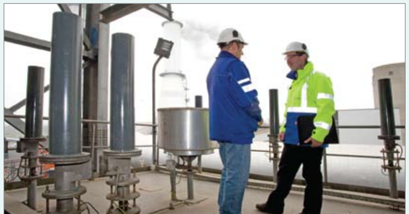
Het afkloppen van de platen gebeurt door een gewicht op te trekken in een elektrische spoel (links en vooraan op de foto) en weer op de plaat te laten vallen. Geert De Mets (Electrabel, links) en Dirk Belet (Fabricom-GTI, rechts).
