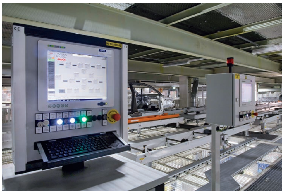
De hoofd- en nevenbedieningspanelen maken deel uit van het modulaire transportsysteem.
