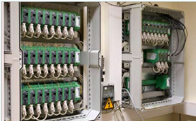
Laborelec herconfigureerde het communicatiegebouwen rond zijn centrale computer. De modems en de T-bus-elementen maken een compacte installatie mogelijk.
