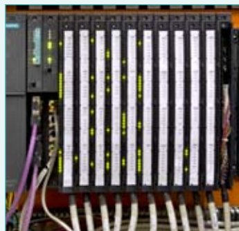
Voor de upgrade van de S5-135U van het conveyorsysteem was maatwerk nodig. Phoenix Contact ontwierp een 50-polige Varioface-kabel met aangepaste pinning.
