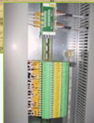
Compacte kastenbouw dankzij 6,2 mm analoge omvormers MINI-MCR
