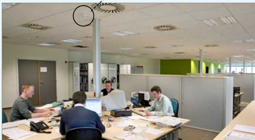
In de salesafdeling is er een bewegingsmelder per bureaueiland. Zit er aan een van de eilanden tijdelijk niemand, dan brandt er ook geen licht.
