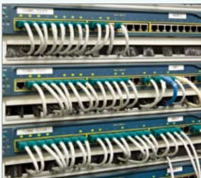
Enkele jaren geleden vervingen we alle kantoorhubs in de fabriek door Ethernetswitches die via glasvezel met elkaar verbonden zijn. Dankzij Profinet kunnen we die investering nogmaals benutten.
