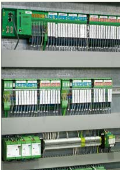
Sinds kort sturen we onze latexmachine aan met een ILC 370 van Phoenix Contact met Ethernet-koppeling.
